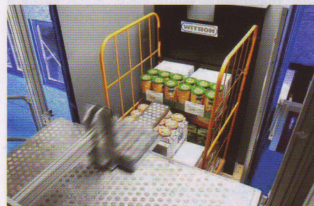
Doplňovací ulička s dopravníky, shrnovacím zařízením a autonomním vozíkem se nachází mezi regály
